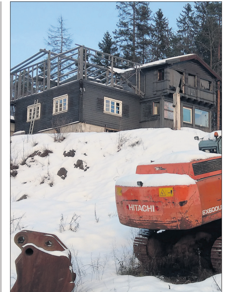
PÅ SISTE VERSET: Bærum kommune har bestemt at dette huset skal rives. FOTO: NILS H. HARNES
